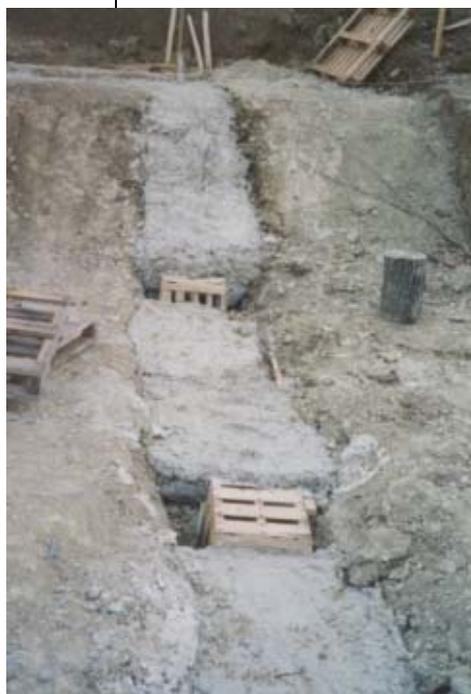
Réservations faites dans une première fondation pour la reprise sur une seconde fondation à couler perpendiculaire
